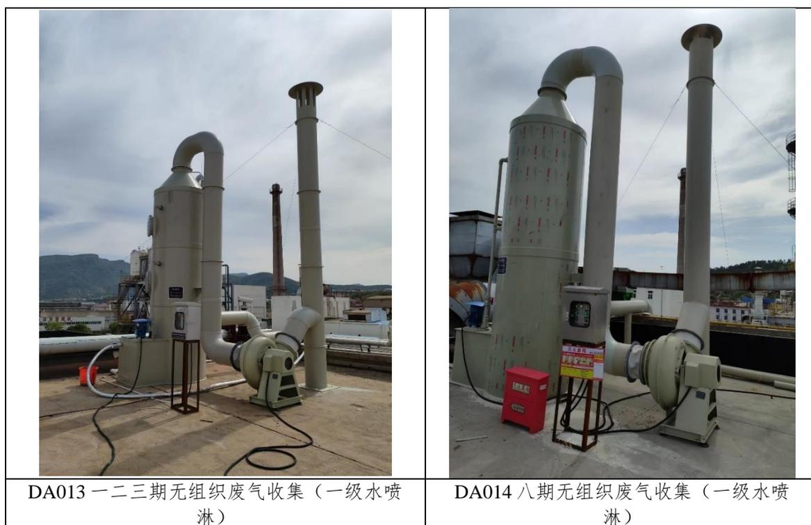
图 2.5-2 有组织废气处理现状及排气筒设置照片
