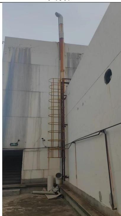
DA011 精制机组废气（二级水吸收+光催化氧化+一级水吸收）
