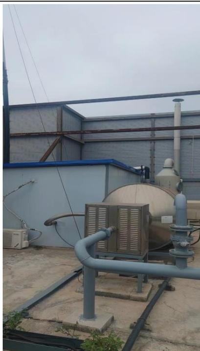
DA007 精制备用机组废气（光催化氧化+一级水吸收）
