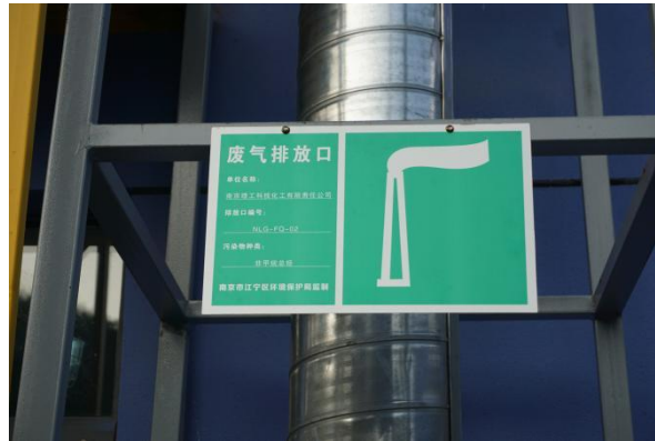
图 8-3 废气排口标识牌
