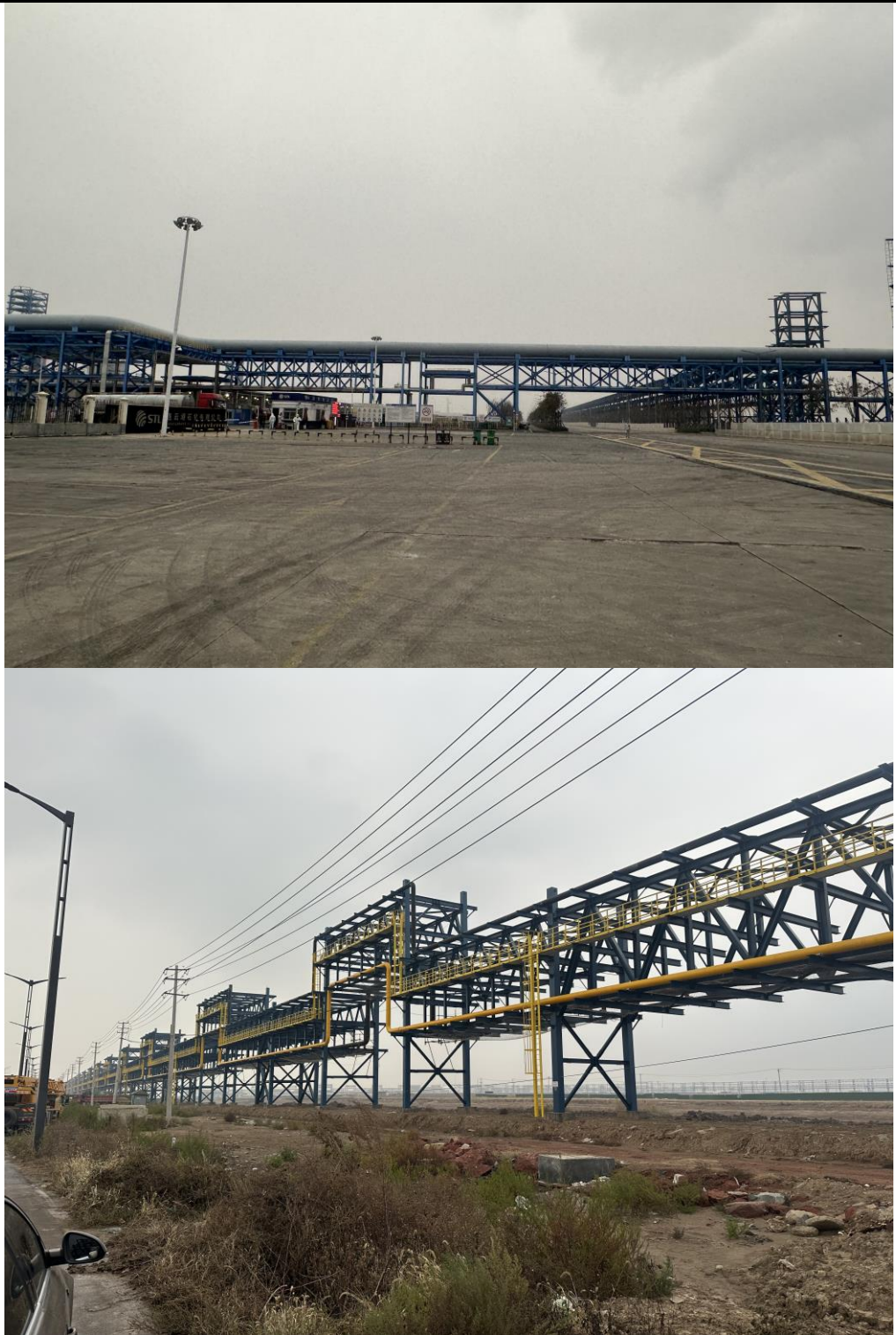
图 2-1 园区现有管廊现状照片
