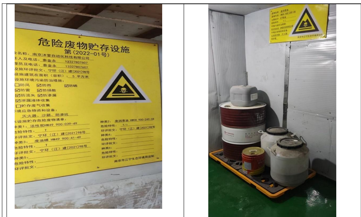
图 3-4 厂区危废仓库实际建设情况
